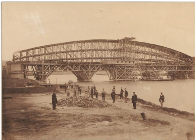
Spoorbrug bij Culemborg in aanbouw
